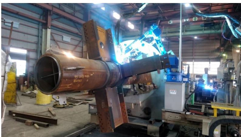
【柱溶接ロボット】
