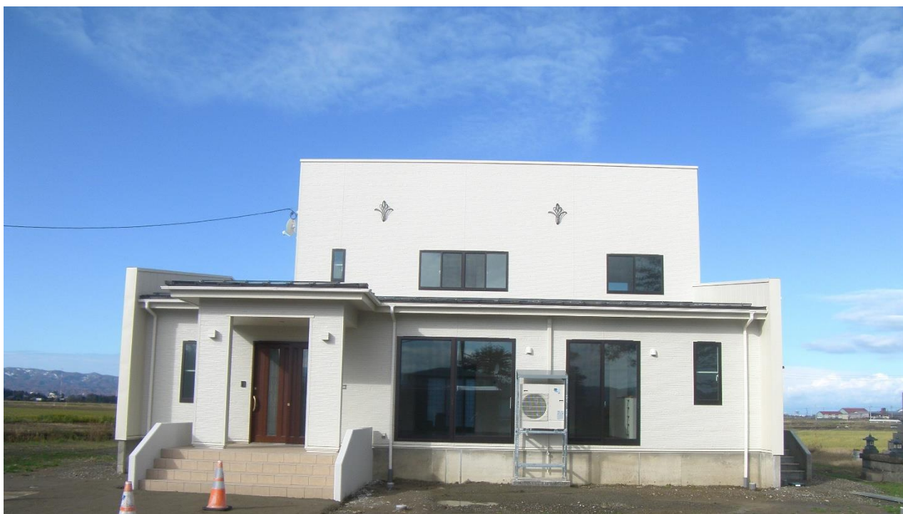
【木造建築（W様邸新築工事）】
